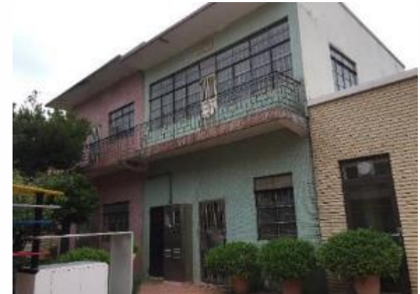
已由新鴻基地產翻新，供非政府機構使用的樓宇
